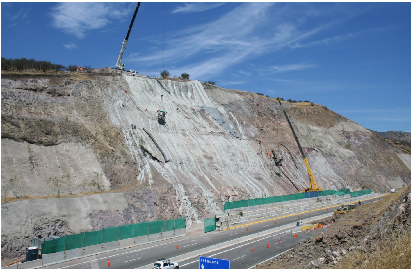
Figura 1 - Vista general de la reparación zona superior y zona inferior (simultánea)
