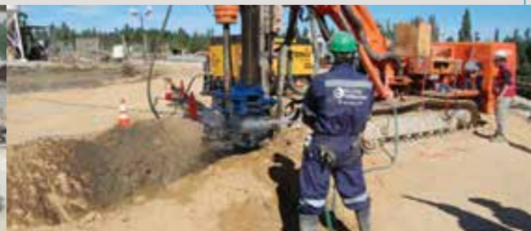
Cortina de Impermeabilización de Jet Grouting Central Hidroeléctrica Laja Chile
