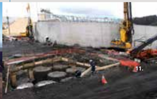
Pilotes y Jet Grouting Tratamiento de Suelos Reactor Biológico Planta Constitución Celulosa Arauco Chile
