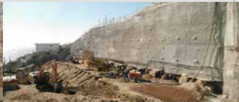
Soil Nailing Vertical Edificio Las Perlas, Viña del Mar Chile
