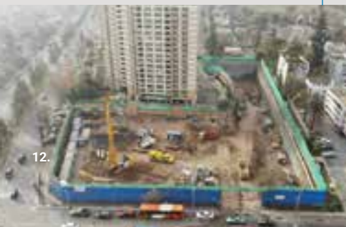
Entibación con Pilotes Anclados con Excavación Masiva Edificio Príncipe de Gales con Av. Ossa Chile
