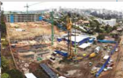
Pilotes CFA de Fundación en Terrenos Licuables Edificio Los Almendros, Reñaca, Viña del Mar Chile
