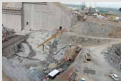
Cortina de Inyecciones en Galerías Central Hidroeléctrica Angostura Chile
