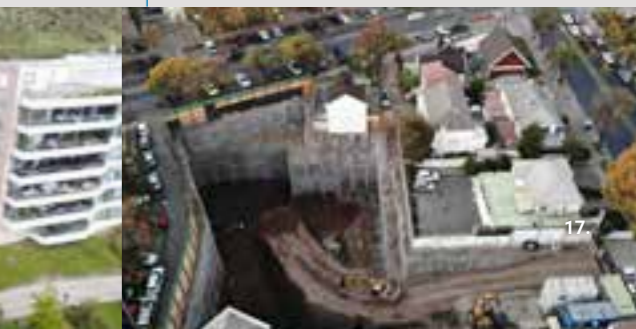
Entibación con Pilotes Anclados y Excavación Llave en Mano, Edificio Alonso de Córdova 2382, Chile
