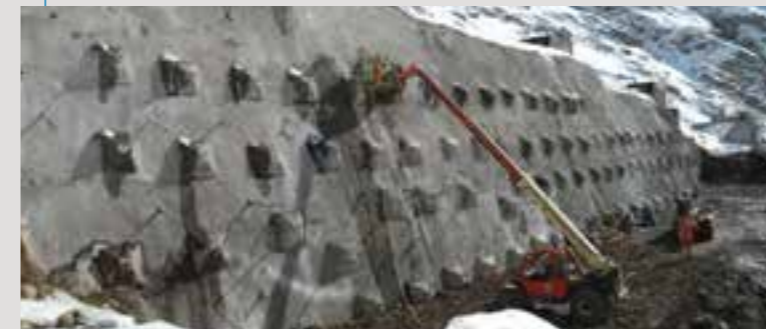
Anclajes Postensados Permanentes Fortificación Planta Cordillera - Codelco Andina Chile.
