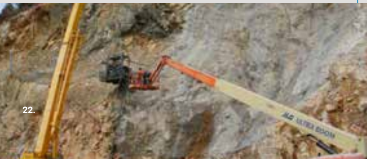
Sostenimiento con Soil Nailing Paso Internacional Pehuenche Chile
