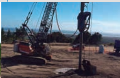
Columnas de Grava con Pre-perforaciones Parque Eólico Raki Chile.
