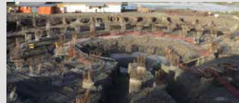
Pilotes de Fundación Planta Constitución Celulosa Arauco Chile
