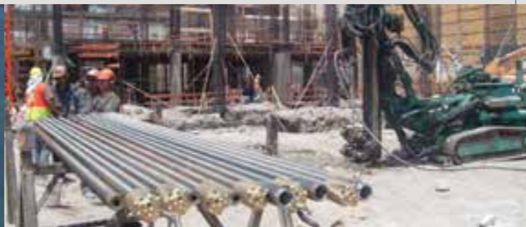
Micropilotes de Fundación Hospital Juan Noé de Arica Chile
