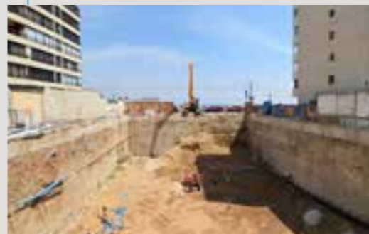
Muro Pantalla Anclado con Excavación Masiva Edificio Bahía Mar, Viña del Mar Chile
