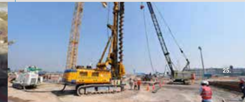
Pilotes Pre-excavados y CFA de Fundación Ø 800, 1000 y 1200 mm Ampliación Aeropuerto de Santiago Chile
