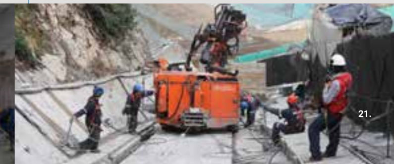
Cortina de Inyecciones Embalse Ancoa Chile
