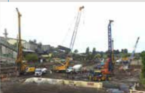
Pilotes de Fundación y Mejoramiento de Suelos con Columnas de Grava, Modernización Planta Laja Etapa 2 Chile
