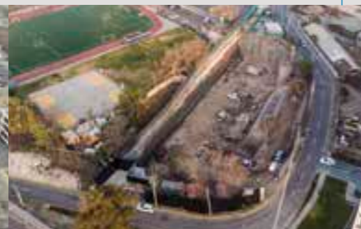
Sostenimiento con Muro Anclado SNX y Anclajes Postensados Edificio David Bengurion, Lo Barnechea Chile
