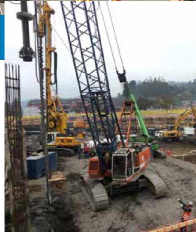
Ejecución Pilotes CFA.
