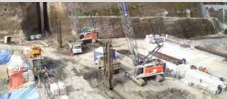
Cortina Impermeable, Muro Pantalla Central Hidroeléctrica, Rucatayo Chile
