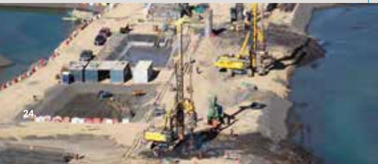
Pilotes de Fundación Puente Laja Chile
