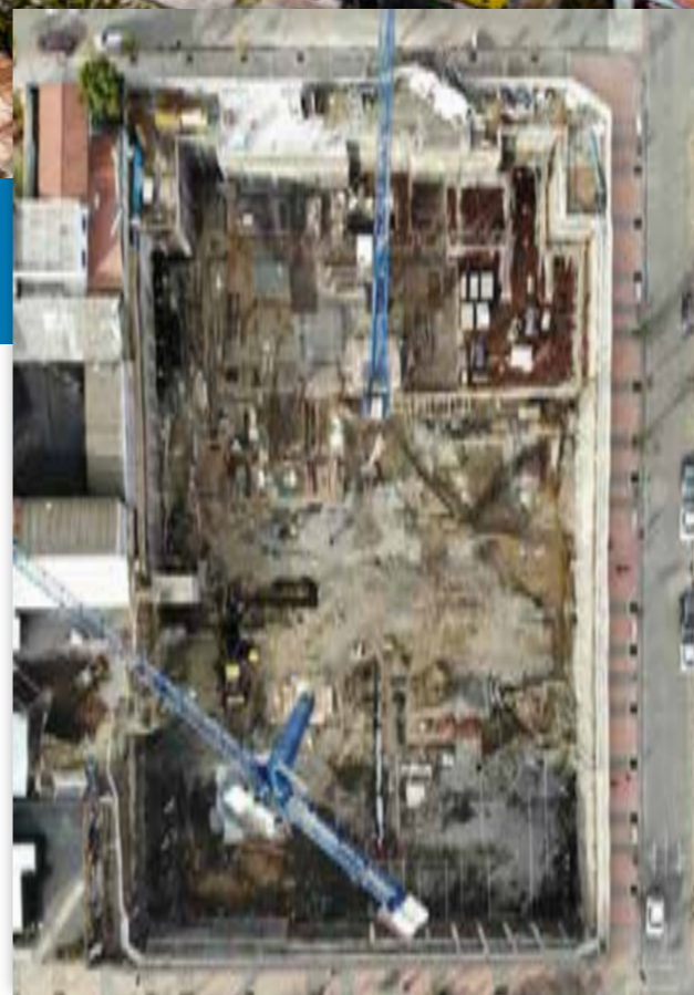
Vista aérea de la obra.
