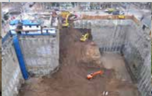
Pilotes y Anclajes Postensados Escuela de Ingeniería, Universidad de Chile Chile
