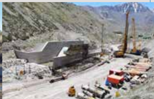
Pilotes de Fundación y Pantalla de Pilotes Bocatoma El Yeso, Santiago Chile
