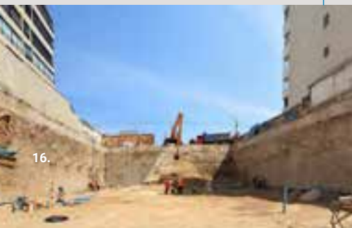
Entibación con Muro Pantalla Anclado Edificio Bahía Mar, Av. Perú, Viña del Mar, Chile
