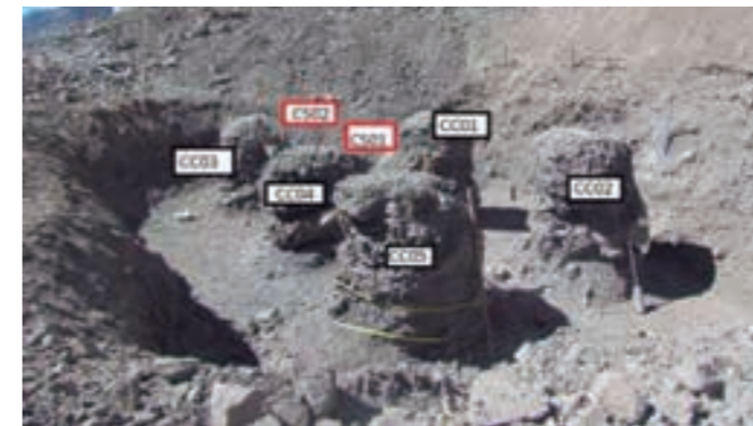
Cancha de Pruebas Columnas de Grava.
