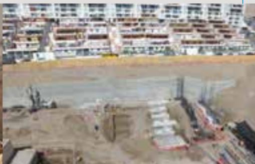
Soil Nailing en Arena de Duna Edificio Inacap Iquique Chile
