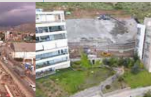
Sostenimiento de Terreno con Soil Nailing Edificio Carlos Peña Otaegui, San Carlos de Apoquindo Santiago, Chile
