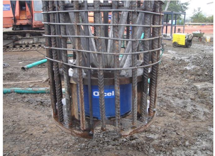
Figura 9 - Celda o Célula de Osterberg (O-cell).
