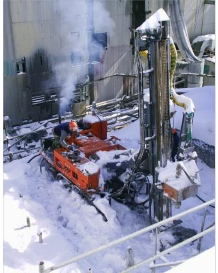
Foto 15 a 18 Sector Eje 13 /14 – Ejecución de micropilotes
