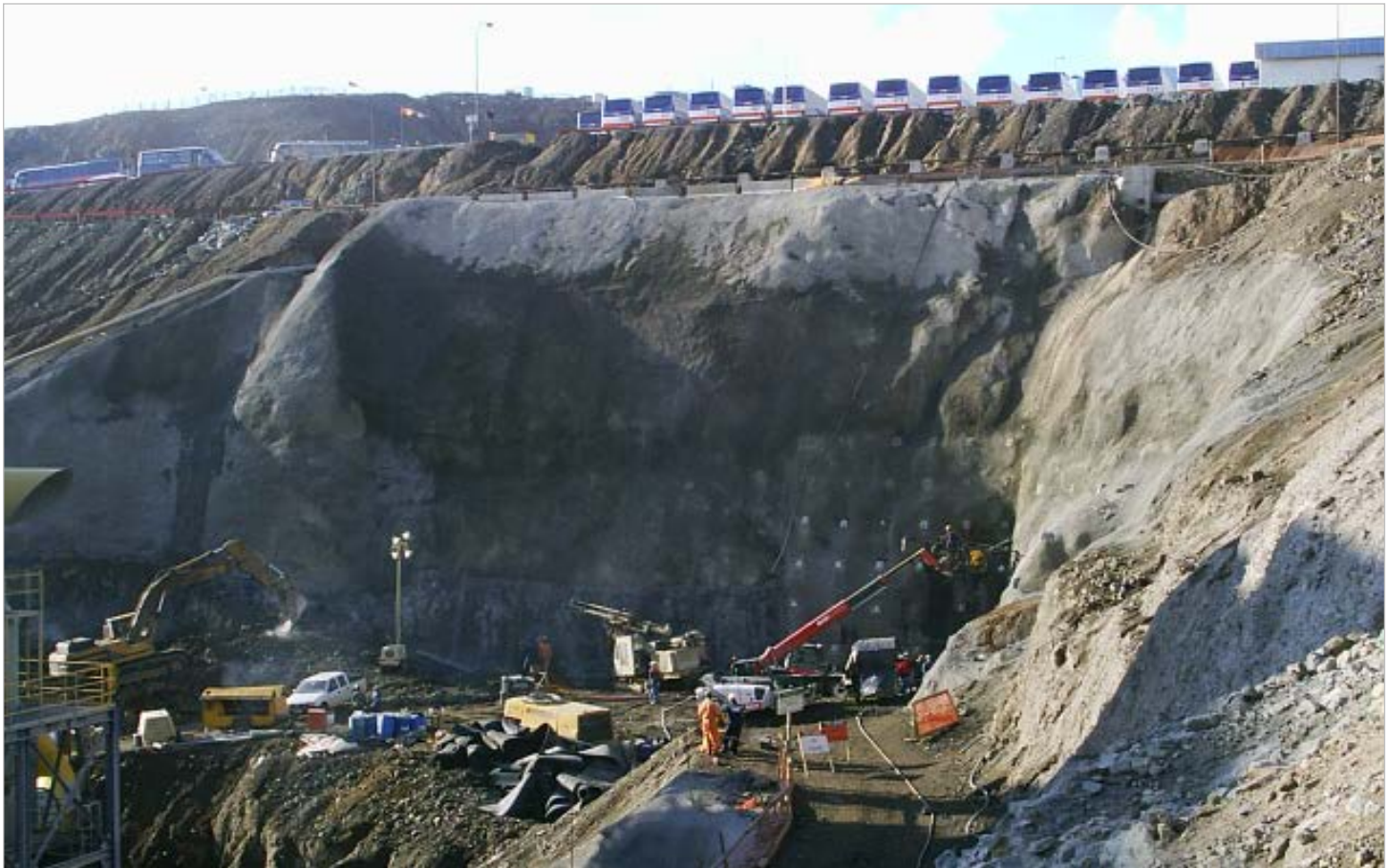
Foto 9 Sector Torre de Transferencia N°2 – Ejecución de anclajes
