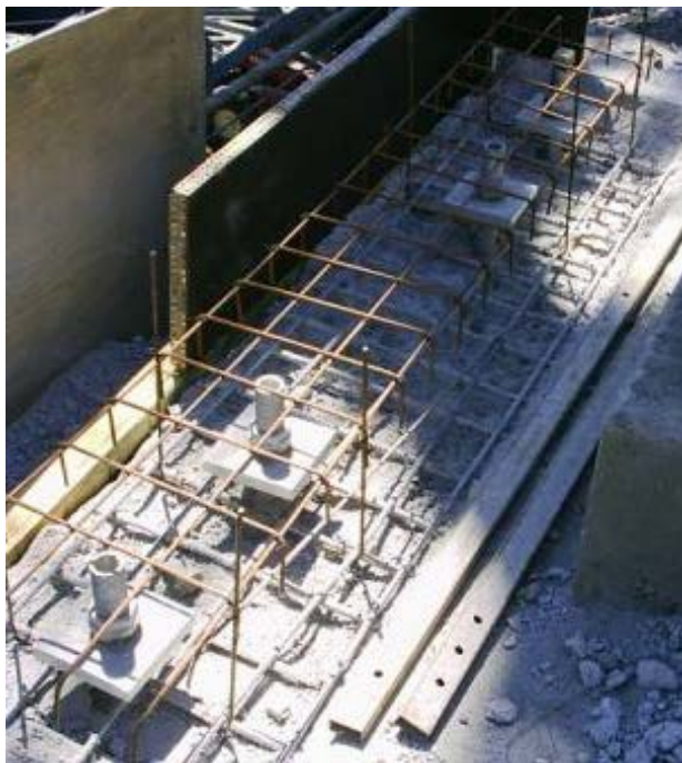
Foto 5 Sector Harneo Terciario – Detalle unión micropilotes con fundación
