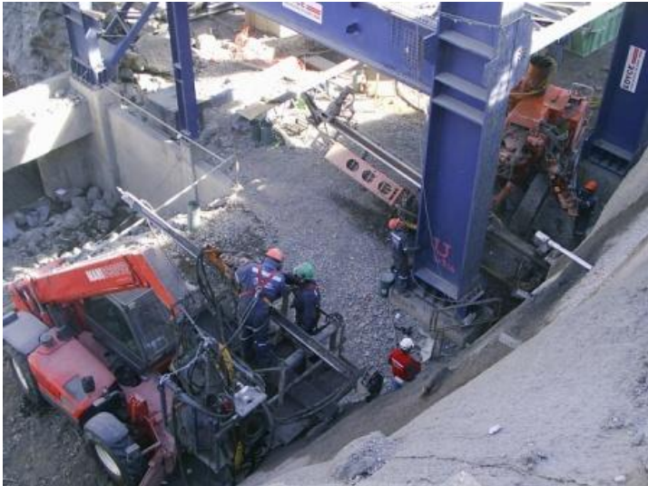
Fotos 6 y 7 Sector Hurneo Terciario – Ejecución de anclajes
