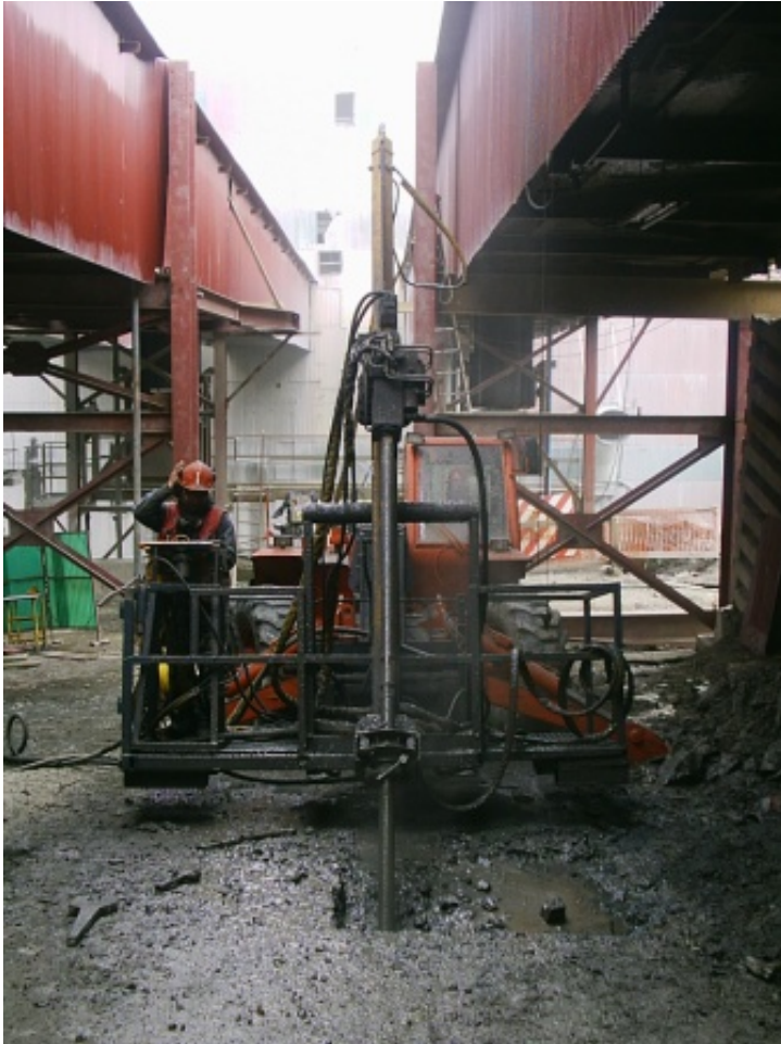
Fotos 22 y 21 Sector Correa CV 29-30y 31 – Ejecución de micropilotes
