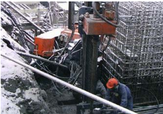
Foto 15 a 18 Sector Eje 13 /14 – Ejecución de micropilotes
