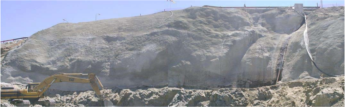
Foto 8 Sector Torre de Transferencia N°2 – Vista general
