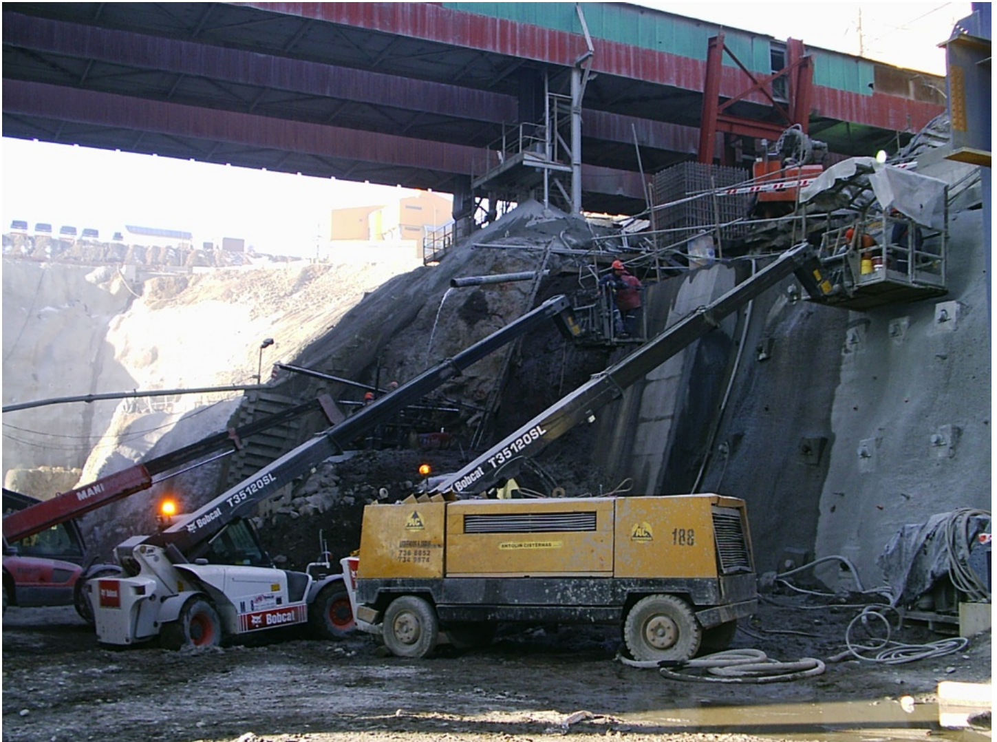
Foto 19 Sector Eje 13 / 14 – Ejecución de Anclajes
