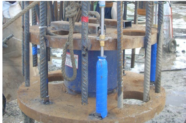
Fig. 2: Instalación de la Celda de Osterberg en pozo pre-excavado.
