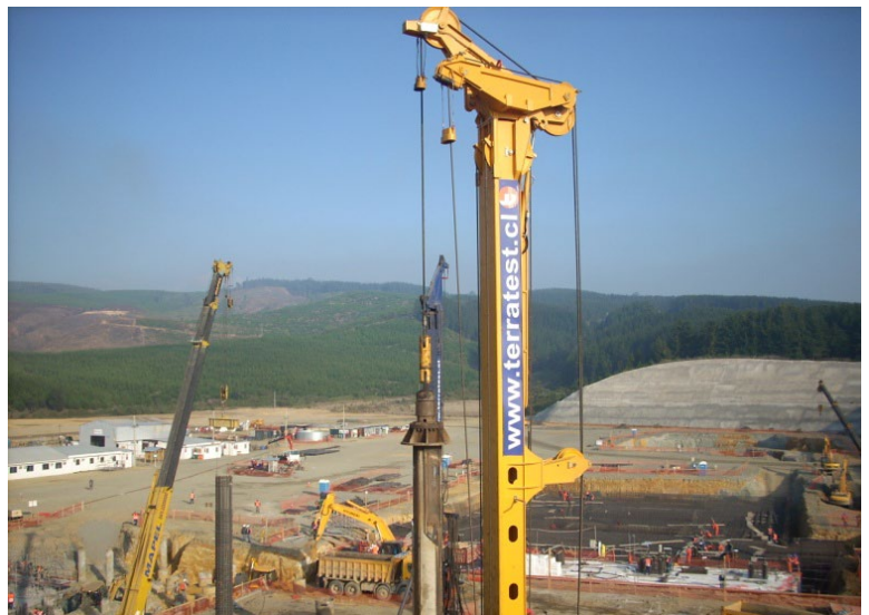
Figura1 : Planta sector Turbine Hall – Steam Turbine (200 pilotes ejecutados).
