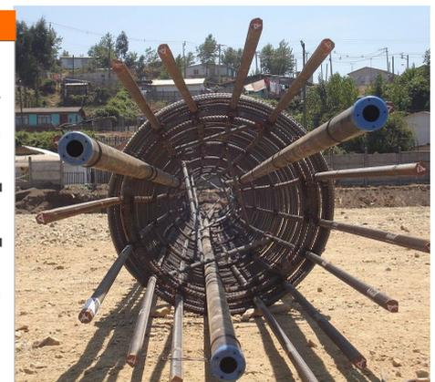
Fig. 11: Tubería Instalada en la armadura.
