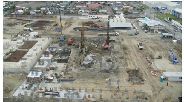
Ejecución de Pilotes sector Turbina (323 pilotes ejecutados).
