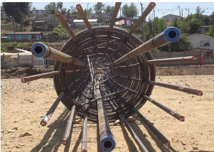
Fig. 9: Tubería instalada en la armadura
