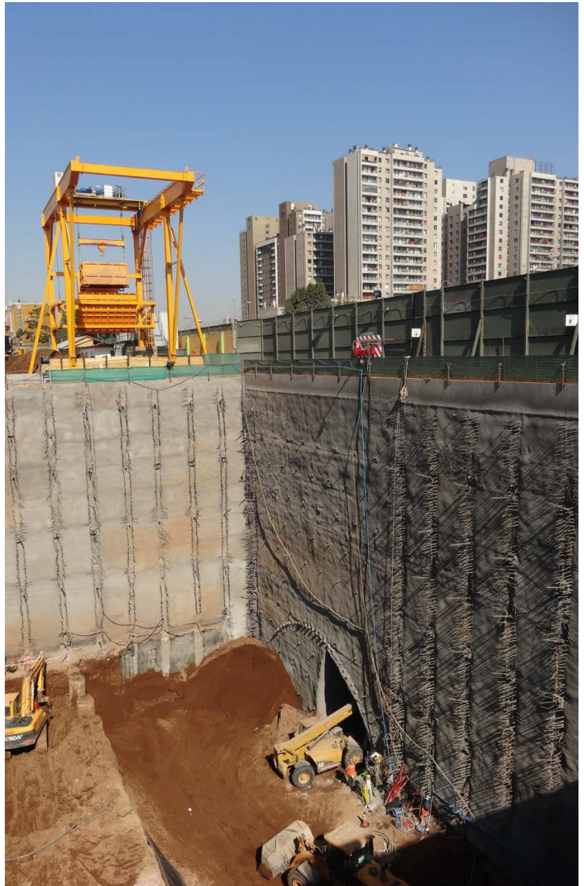
Serie de Fotos 1 - Vista de la Obra Estación Ñuble
