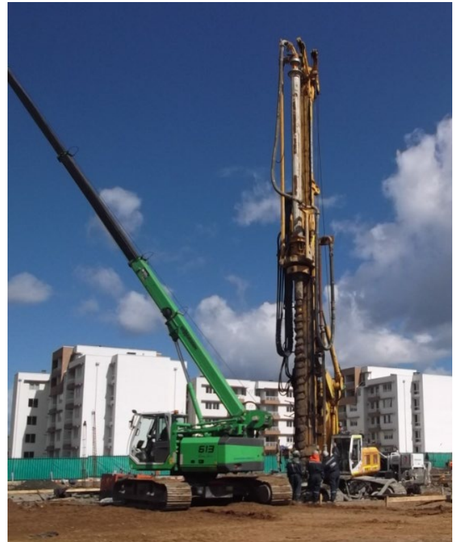
Ejecución Pilotes CFA en la obra.
