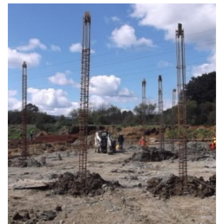
Pilotes Ejecutados previo al corte de excedente.
