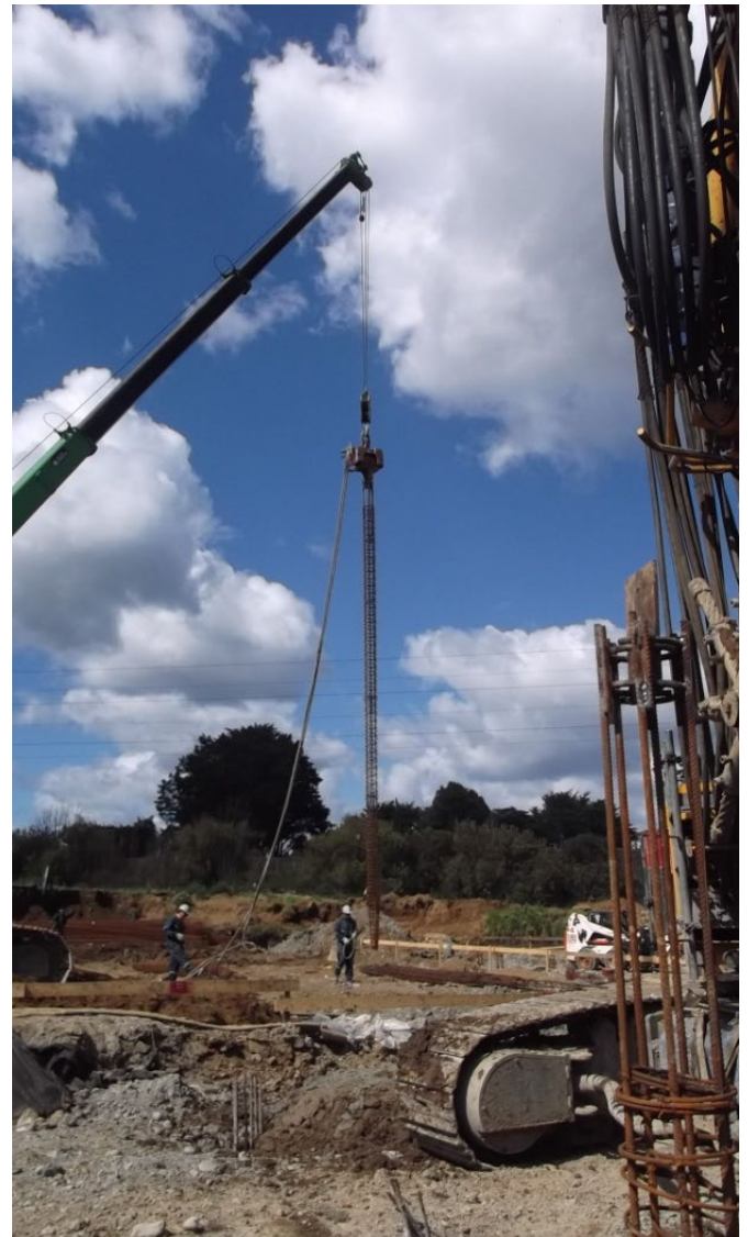
Instalación Armadura mediante vibrado.
