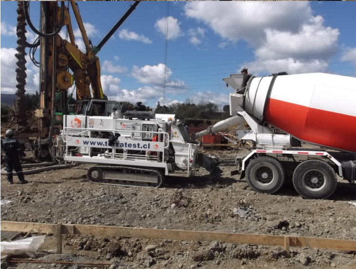
Perforación y Bombeo Hormigón.
