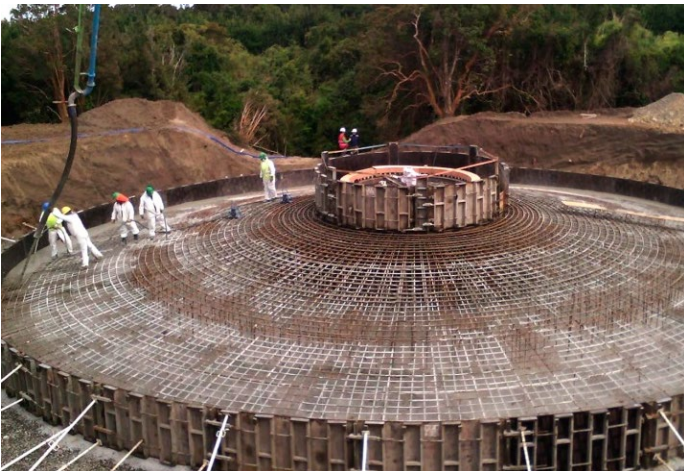
Base torre eólica. (Foto: CJR Wind).
