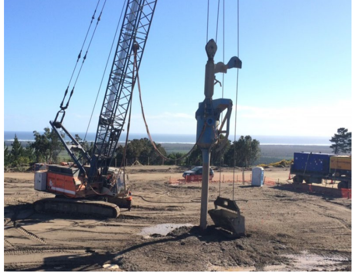
Ejecución Columnas de Grava.
