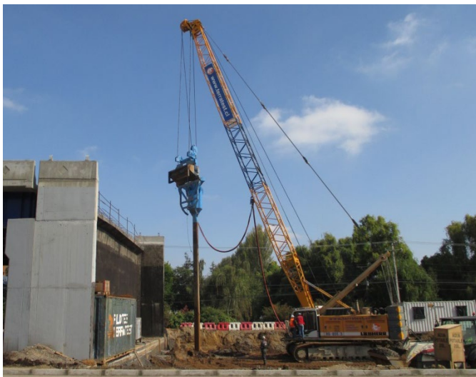
Ejecución de Columnas de Grava.
