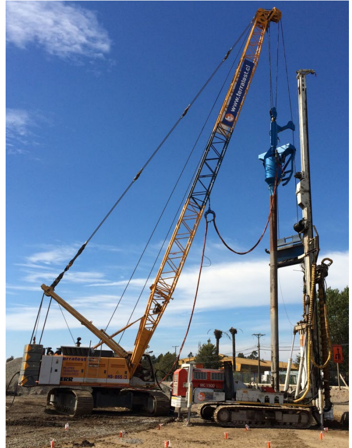
Equipos de Columnas de Grava(atrás) y de Preperforaciones (adelante).
