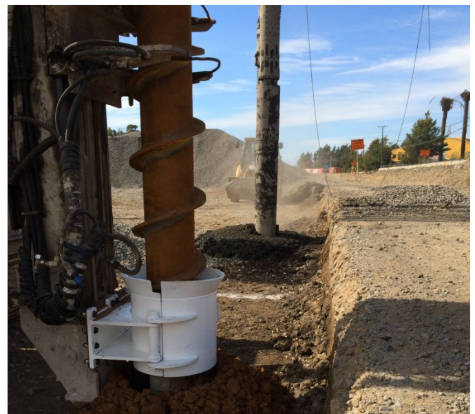
Equipos de Columnas de Grava(atrás) y de Preperforaciones (adelante).
