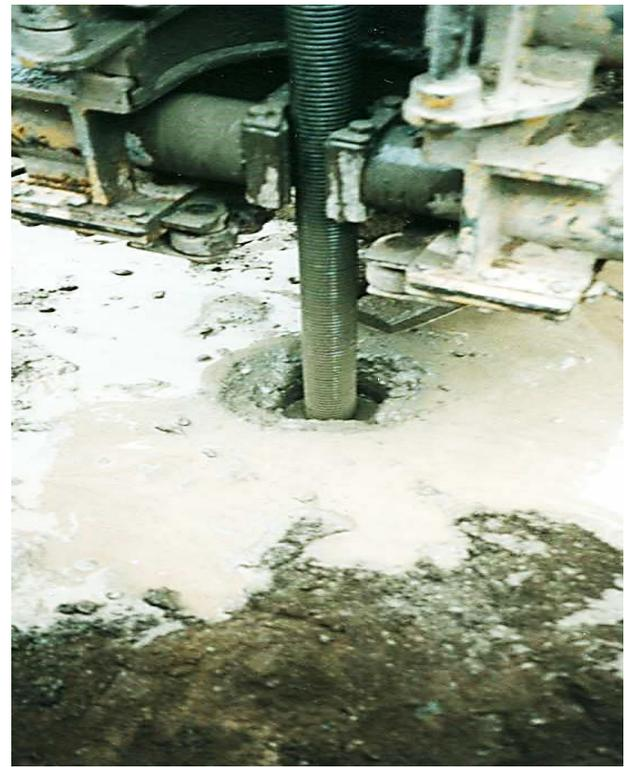
Foto 1 y 2 - Perforación e instalación simultánea de los micropilotes, utilizando como fluido de barrido la misma lechada.
