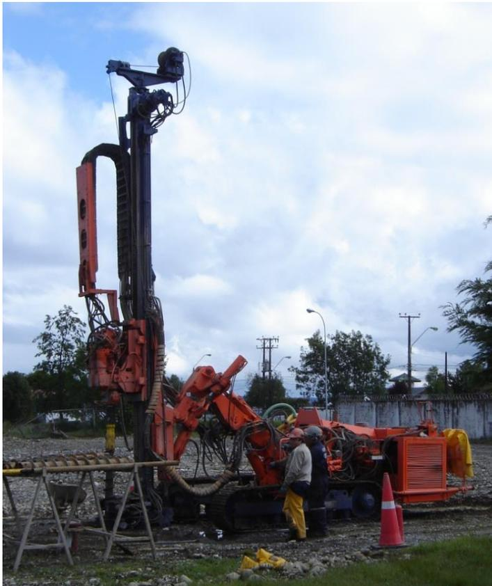
Foto 4 – Sondajes Explanta de abastecimientos de Combustibles – Puerto Montt
