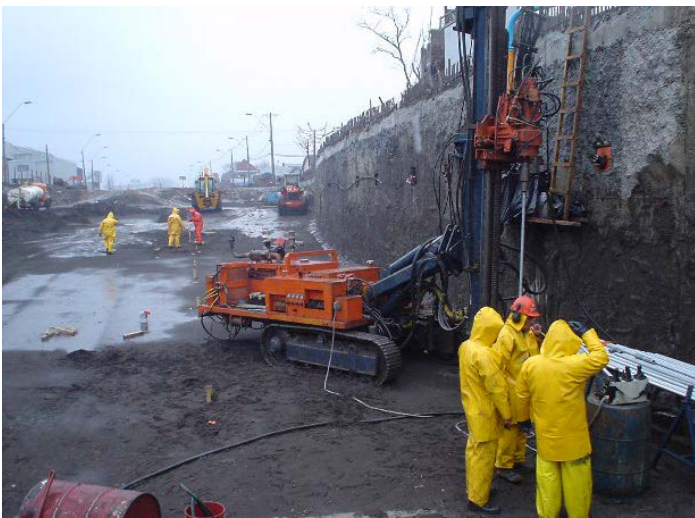
Foto 2 – Ejecución de micropilotes de subpresión
