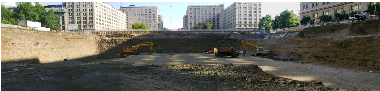
Foto 1 - Vista General de la Obra
