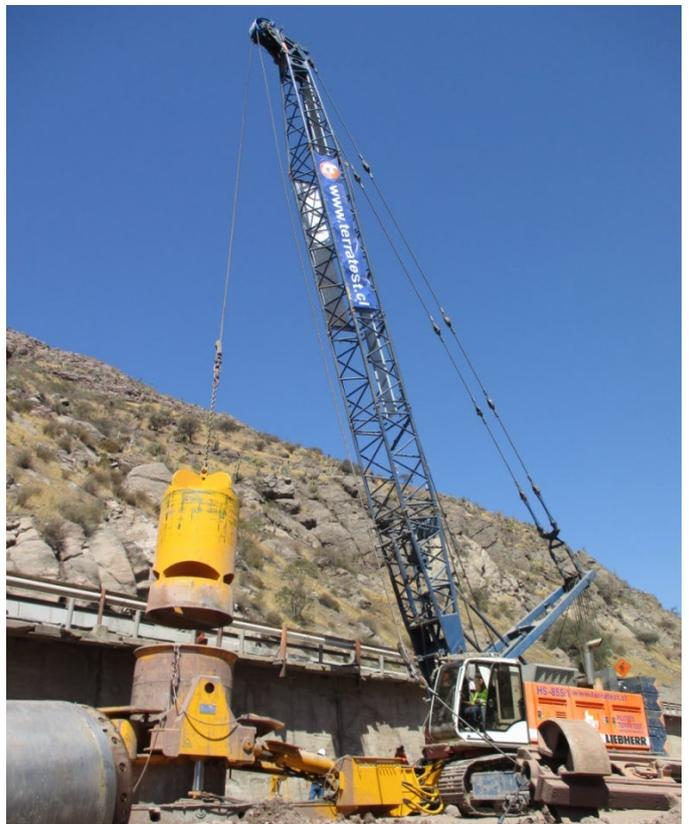
Ejecución mediante Cuchara y Trépano con Camisa Recuperable de Ø2000mm.
