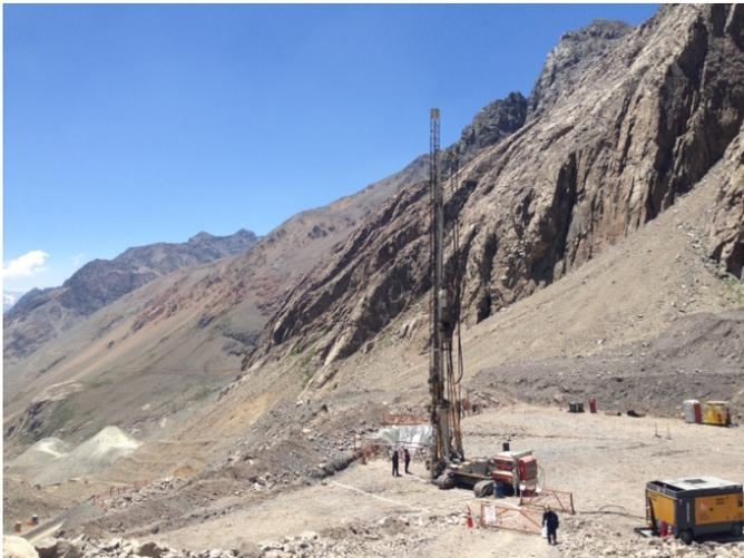
Imagen 5 y 6 – Ejecución de la Pantalla de Jet Grouting.
