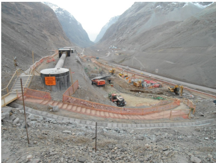
Vista general de inicio de obra.
