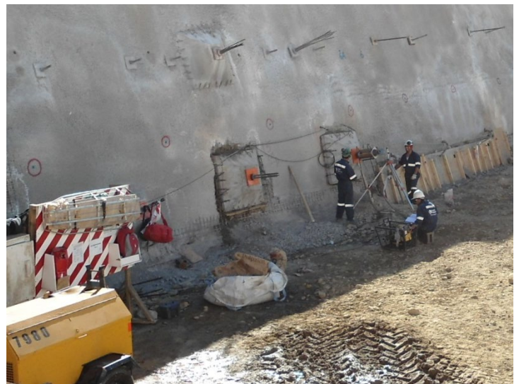
Equipo de tensado de anclajes.
