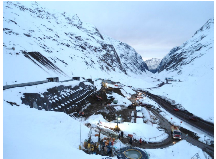
Vista general obra durante ejecución 4° línea.
