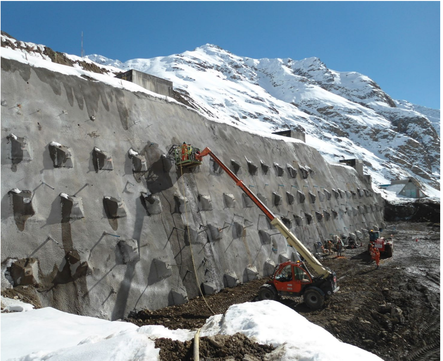
Vista general de la obra.
