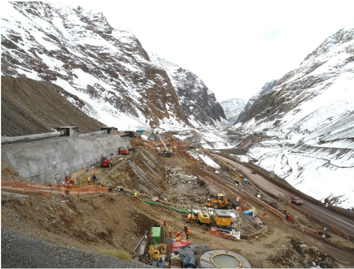
Vista general obra durante ejecución 2° línea.
