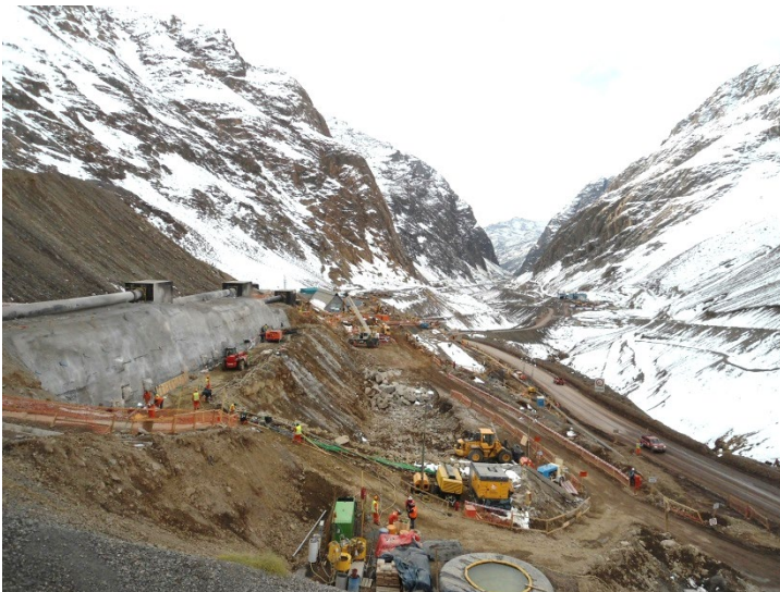
Vista general obra durante ejecución 2° línea.
