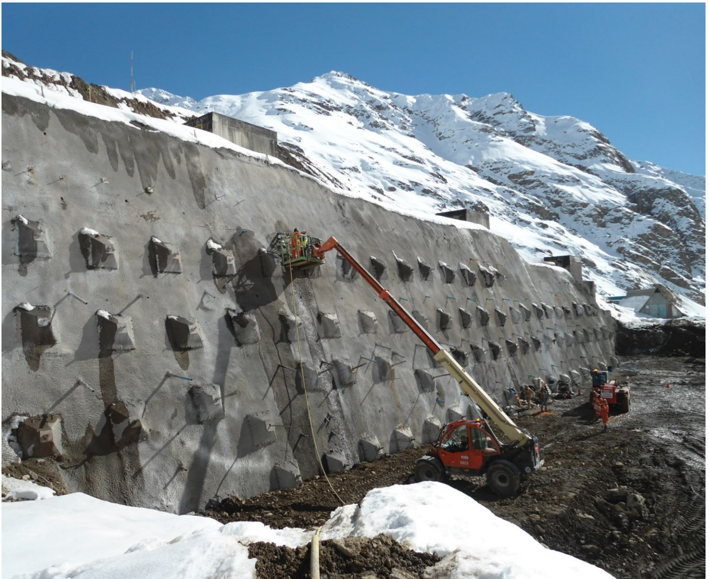
Vista general de la obra.
