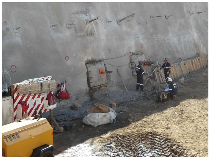
Equipo de tensado de anclajes.
