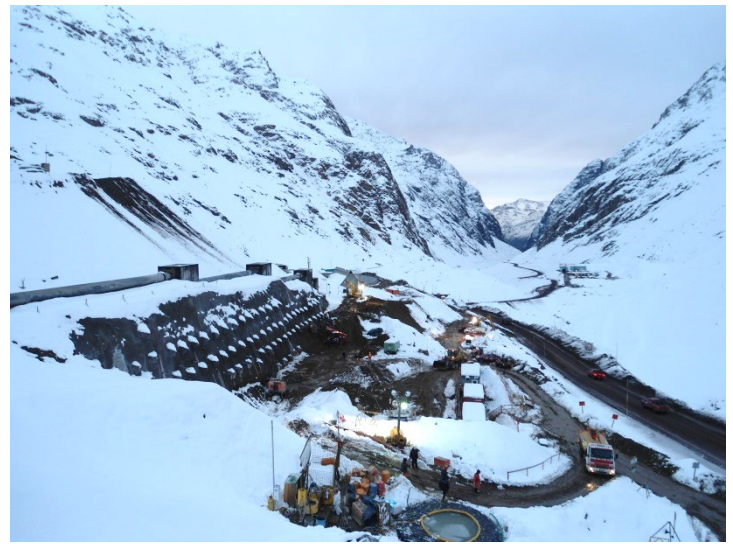
Vista general obra durante ejecución 4° línea.
