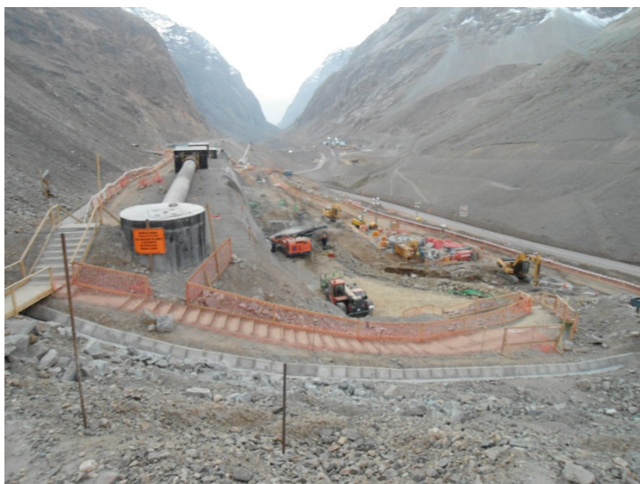
Vista general de inicio de obra.
