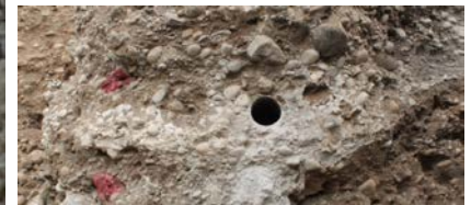
Extracción de Testigo obtenido de cada Columna
