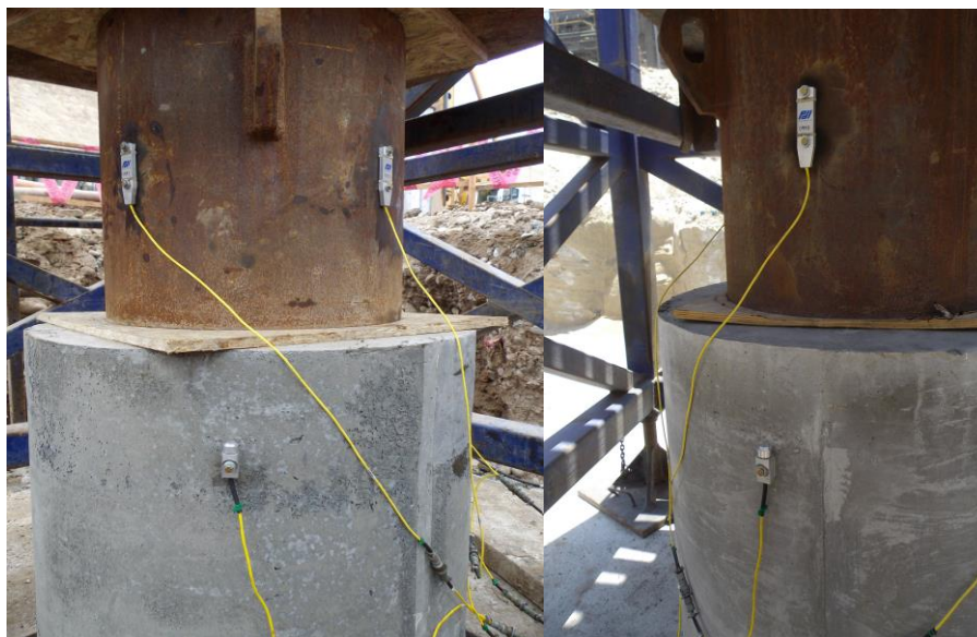
Fig. 1 – Preparación de cabezas de pilotes e instrumentación instalada.
