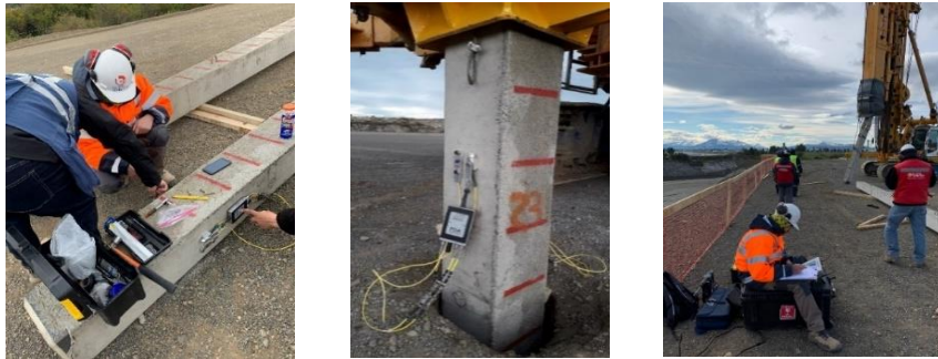
Fig. 1 – Instalación y monitoreo Equipo PDA
