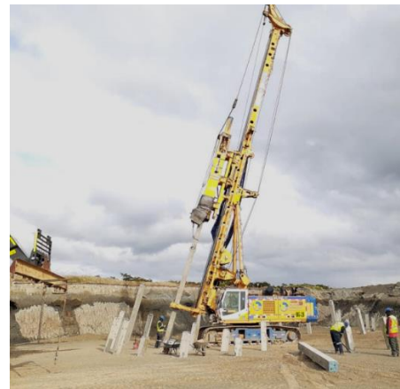
Fig. 10 – Hincada de pilotes inclinados para absorber esfuerzos horizontales
